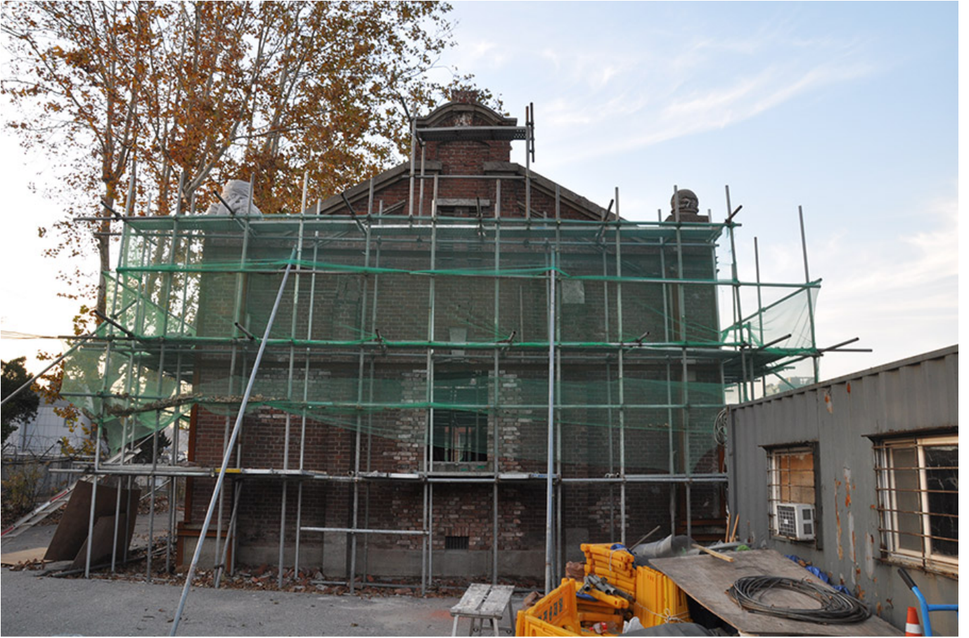
2012년 세관 창고 복원 공사
