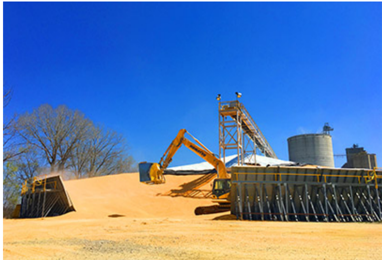
ヤループークの建設現場
