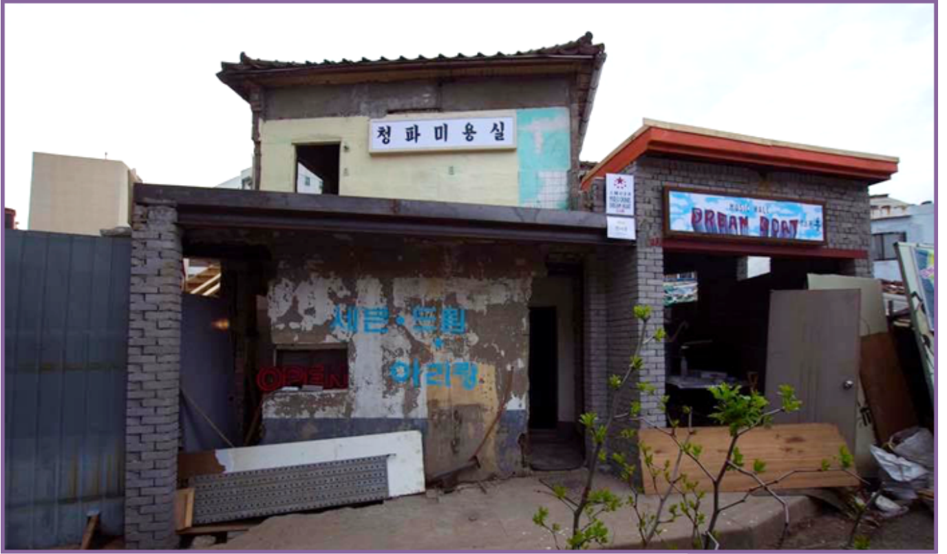
공사 중인 에스컴시티 전시관
